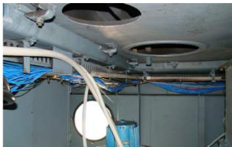
Foto 15 - Cablurile electrice au fost trase în mănunchi, printr-o tubulatură ( Fotografie făcută în timpul montării electrocompresorului )
