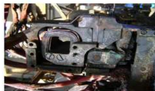
Bobina de suflaj și contactele de rupere de la S4.1
